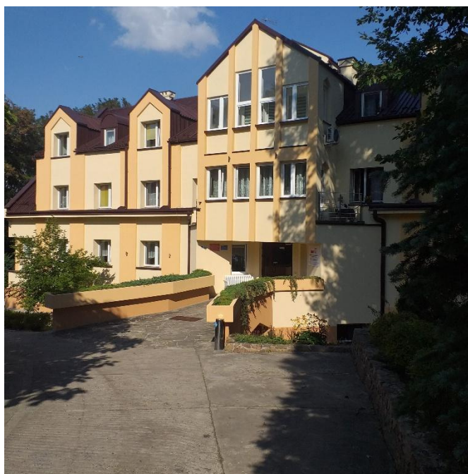
Zdjęcie 1 Wejście do budynku DPS
